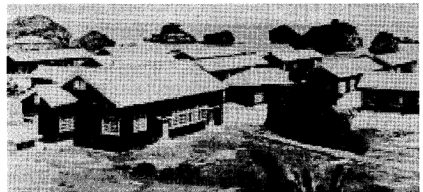
図2 木造瓦葺平屋住宅(居住者棟)
