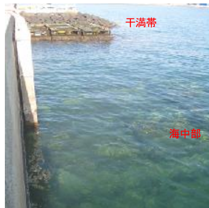
写真-1 暴露場写真
