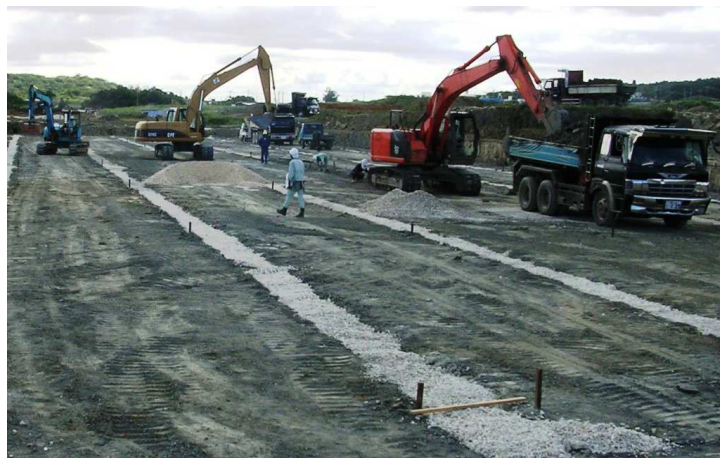
図 5-8 建設機械を用いた暗渠設置
