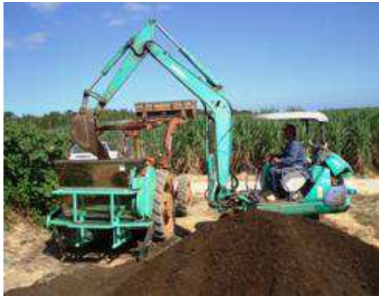
(a) バックホーによる積込 バックホー出力 29.4kw バケツ容量 0.15 m 3
