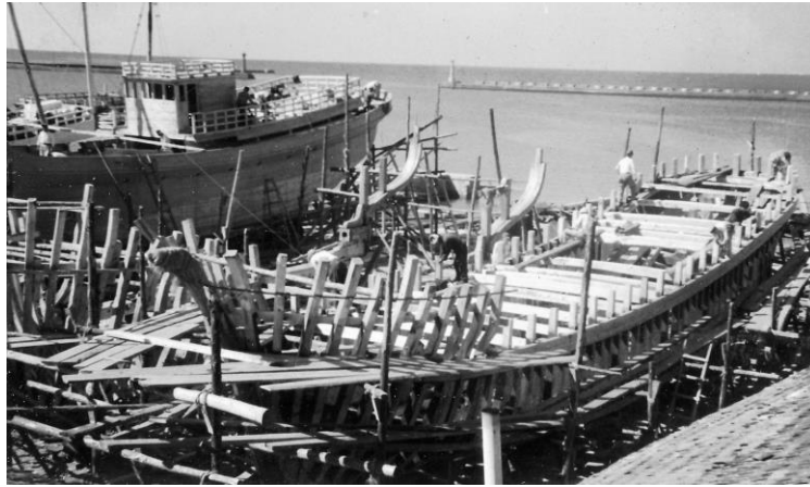
マグロ漁船の建造 (岡下造船)
