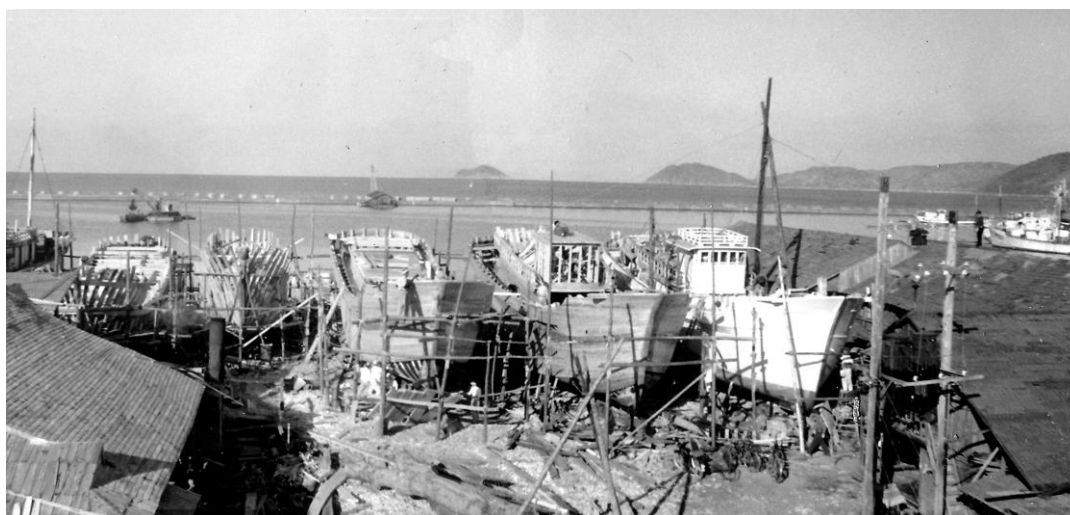
マグロ漁船の建造（昭和 34 年，岡下造船）
