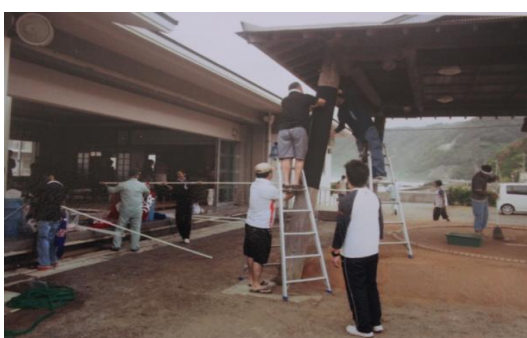
図 5-10 豊年祭で男性が土俵を修繕する様子 (1)
