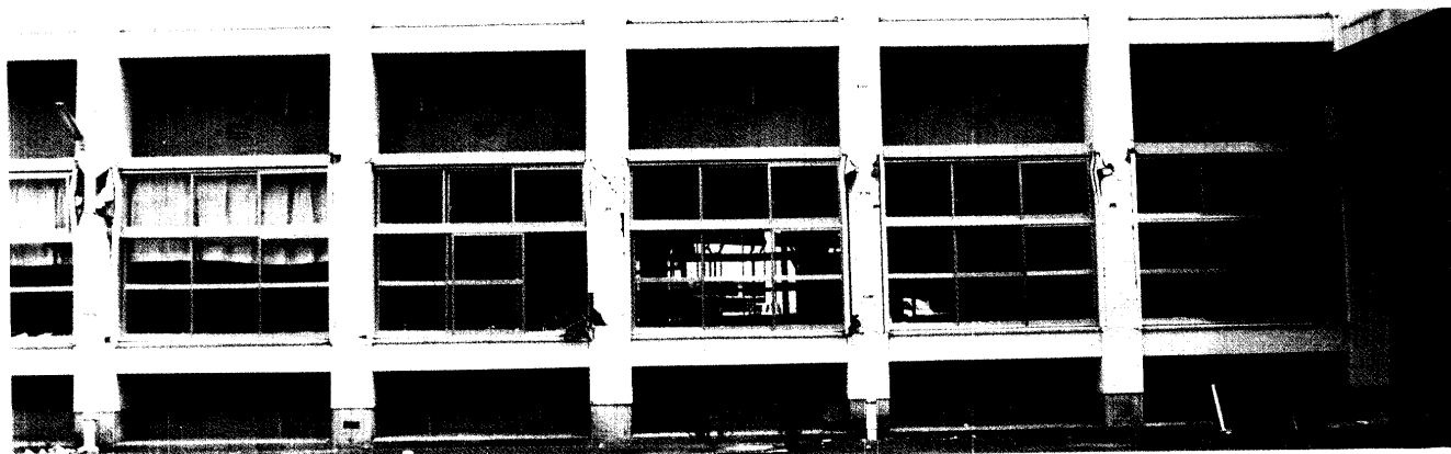
写真-2.14 A通り⑦～⑫架構の破壊（8月1日）
