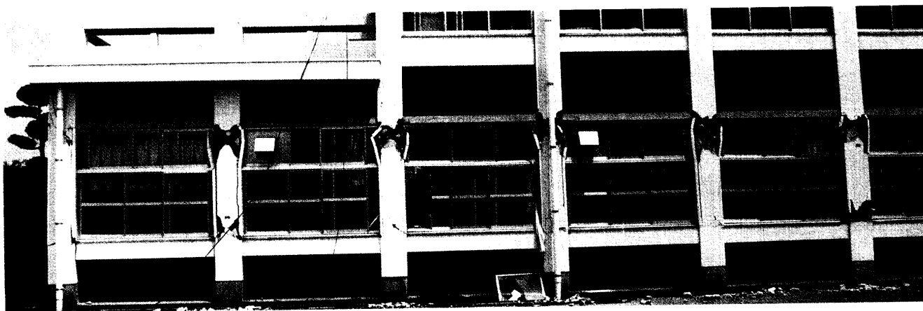
写真-2.13 A通り①～⑥架構の破壊（8月1日）
