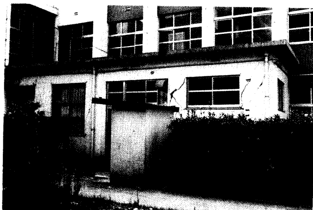
写真-3.16 平屋架構の破壊 (C-⑰~⑳, 9月1日)
