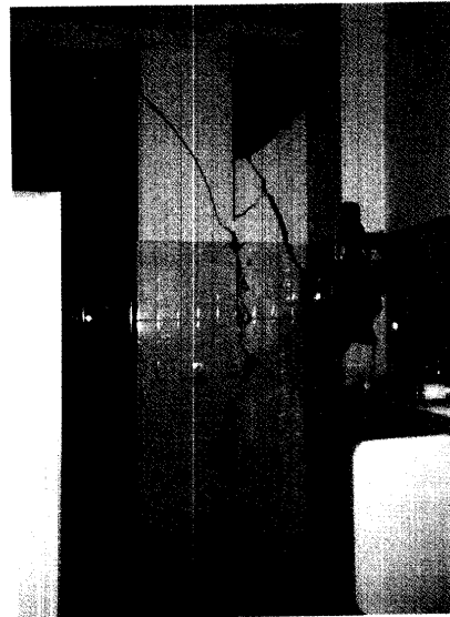
写真-3.5 柱の曲げせん断ひび割れ (B-15, 7月24日)
