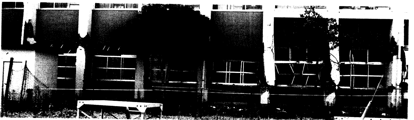
写真-2.18 B通り⑪~⑤架構の破壊 (8月1日)
