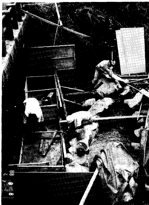
Photo. 3 堰堤右岸側の型わく組み
