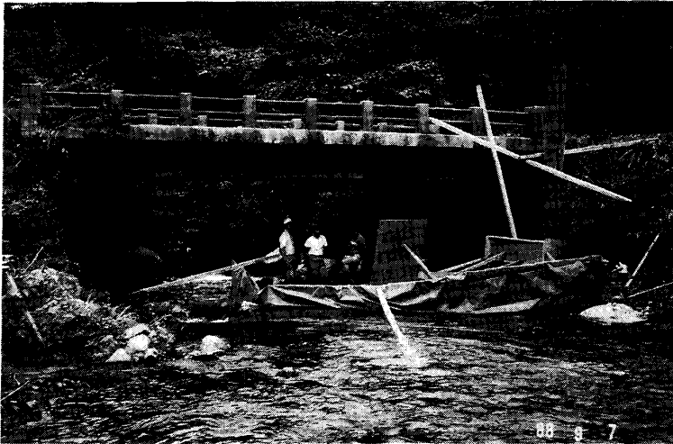
Photo. 2 流水の処理状況 (流水はコンパネとシートにより 溪流の片側に寄せた。)
