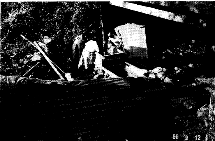
Photo. 6 堰堤左岸側の型わく組み (流水はコンパネとシートにより溪流の片側に寄せた。)
