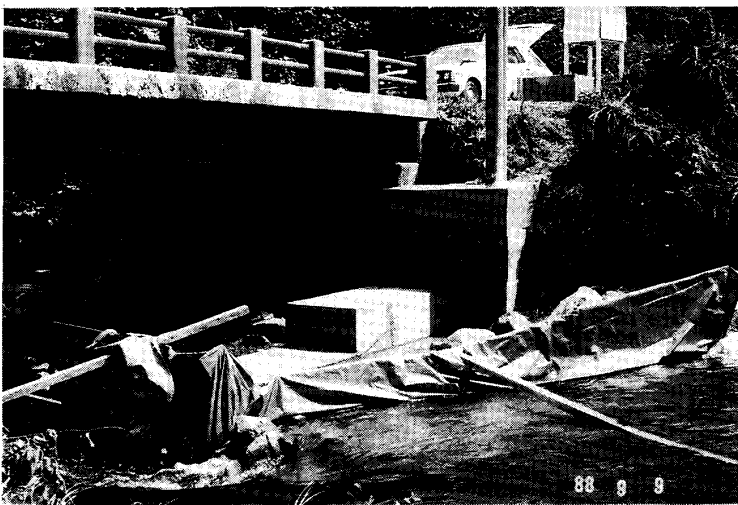
Photo. 5 堰堤右岸側の完成 (右岸側袖部には水位観測井戸用として塩化ビニール管を埋設した。)
