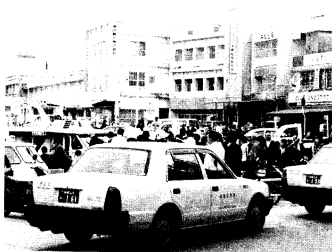
2. 石垣港棧橋の風景
