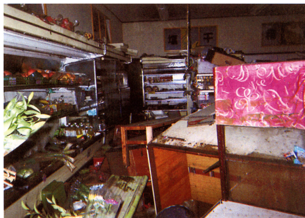
写真一3 機械・設備の被害
